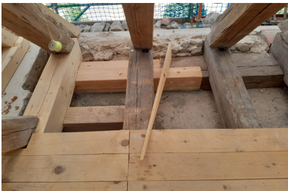
Aktuelles Bild von der Kirchendachsanierung
