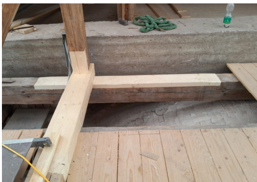
Aktuelles Bild von der Kirchendachsanierung
