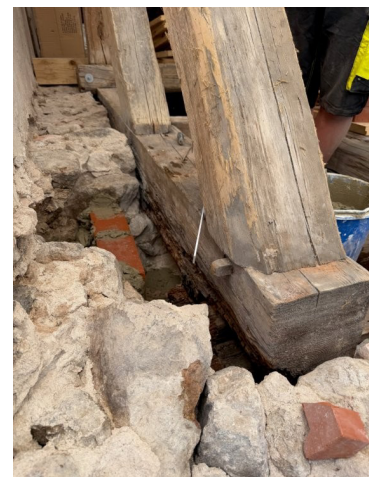
Von Bauschutt freigelegte Fußpfette
