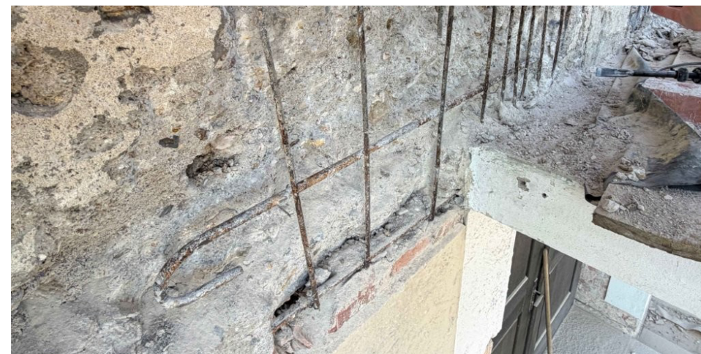
Von Bauschutt freigelegte Fußpfette
