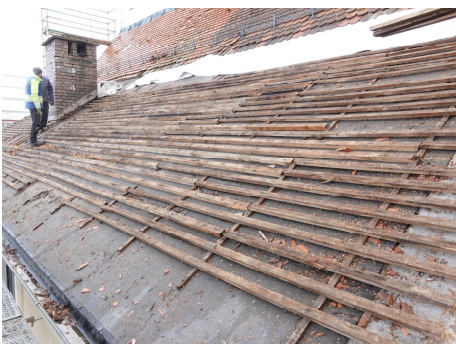
Kirchendach mit alter Dachlattung
