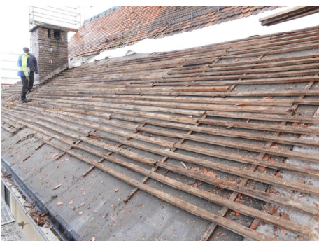
Kirchendach mit alter Dachlattung
