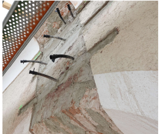
gleiches Fenster: Verpressen des großen Mauerrisses oberhalb eines Kirchenfensters
