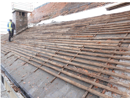
Kirchendach mit alter Dachlattung
